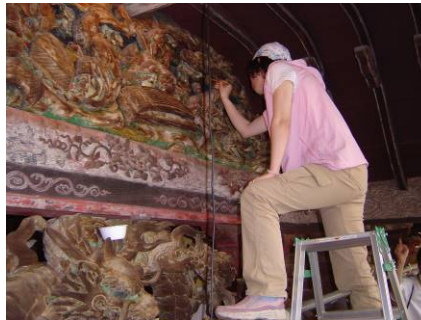
社寺の彩色修理の現場
